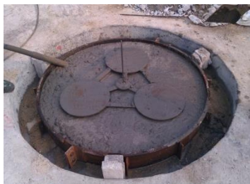
(b) 桩顶二次浇筑
