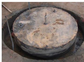
(d) 侧护板与盖板安装
